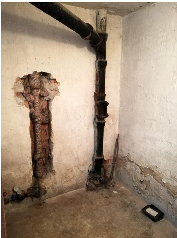
PRÍPOJKA VODY A KANALIZÁCIA V SUTERÉNNEJ STENE
