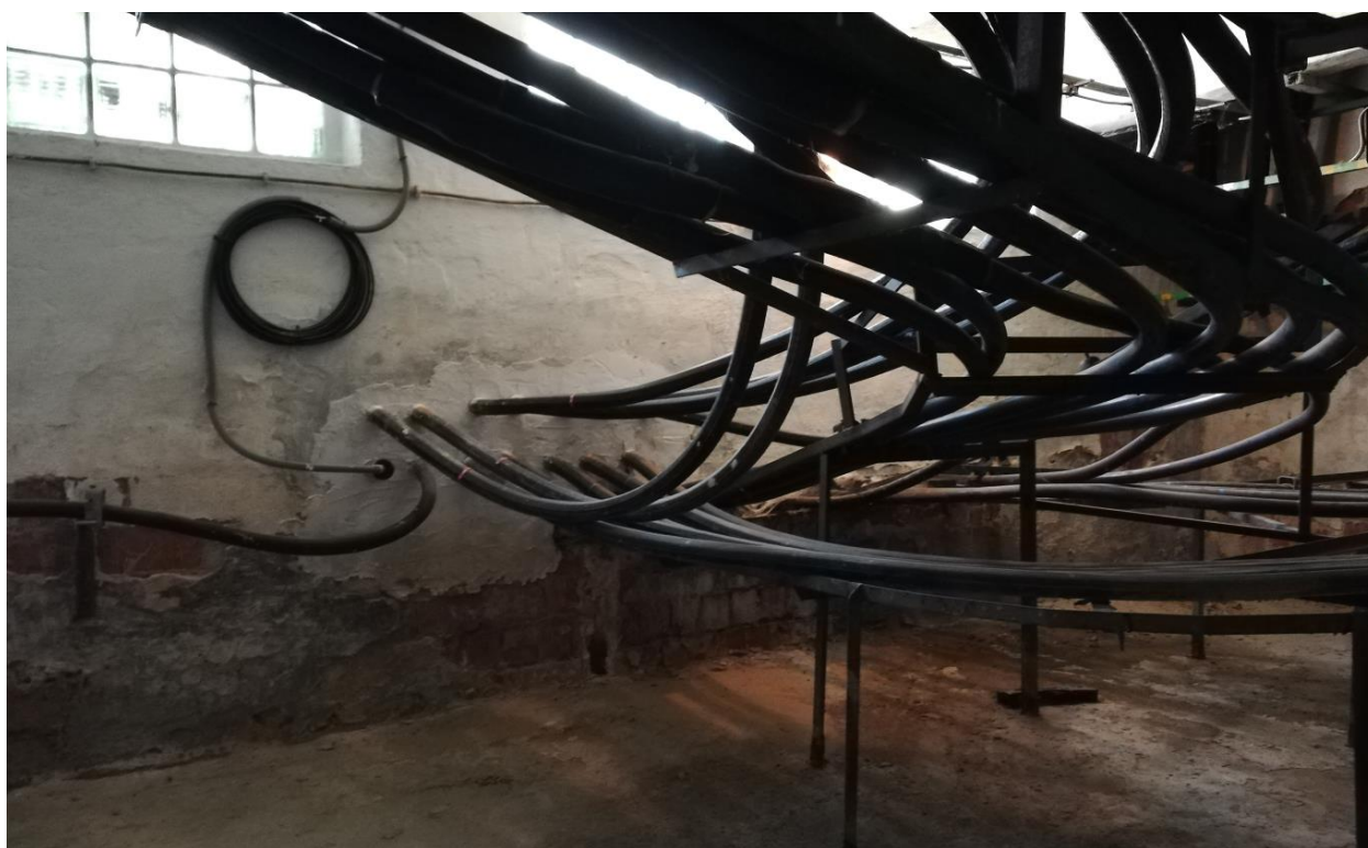
PRECHOD KÁBLOVÝCH VEDENÍ SUTERÉNNOU STENOU
